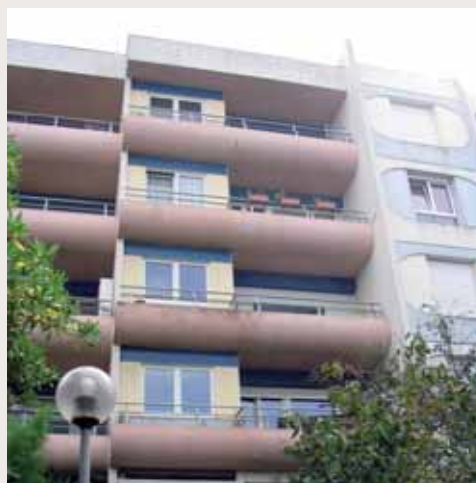
Les Roches, Nantes (44) avant travaux
